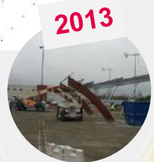
Installation des ombrières
