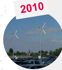
Installation des éoliennes
