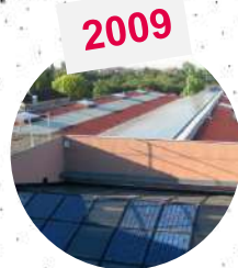
Installation des PV
