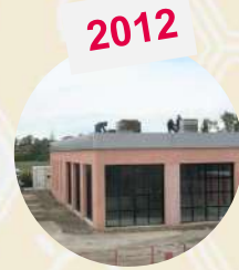
Construction du bâtiment stockage
